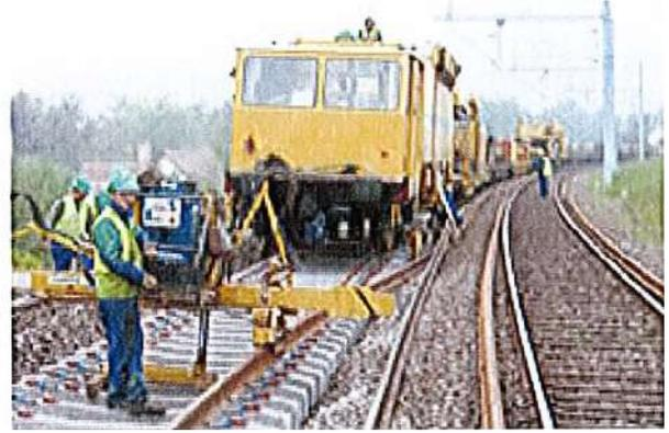
*Longs rails soudés sur traverses béton*
